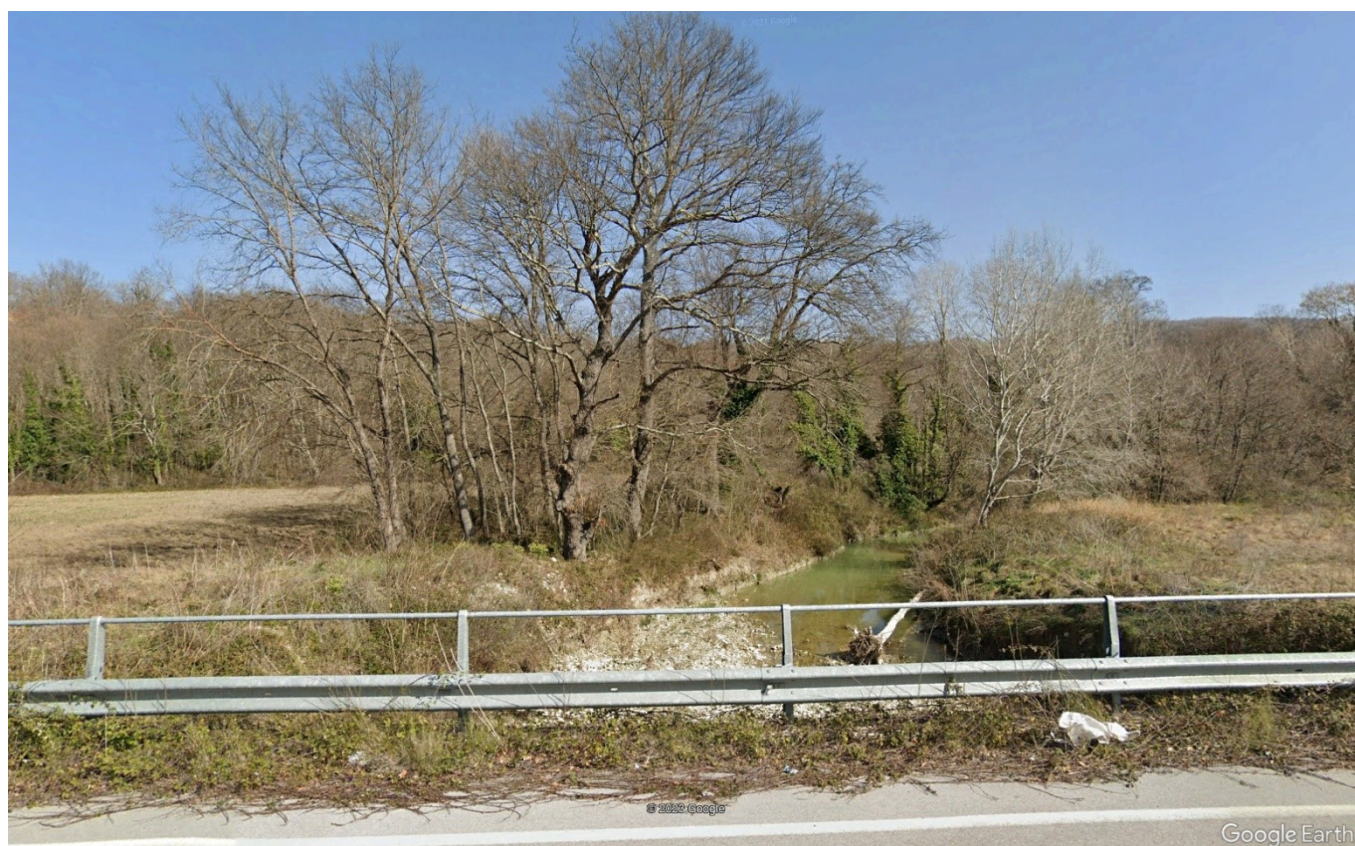
Figura 6 Torrente di Castellelce
