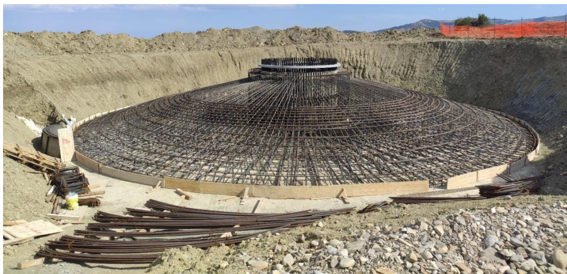
Figura 4: armatura plinto tipo
