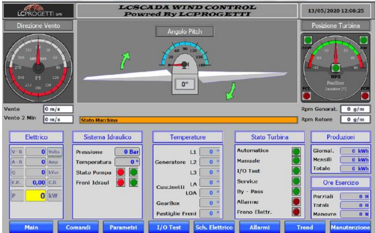
Figura 3 Interfaccia monitoraggio remoto di una turbina in esercizio
