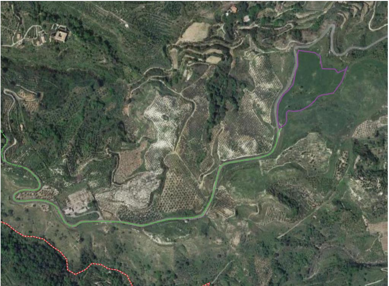
Figura 4-15: Ortofoto area di futura Stazione elettrica utente adiacente alla Stazione Terna "Soverato"
