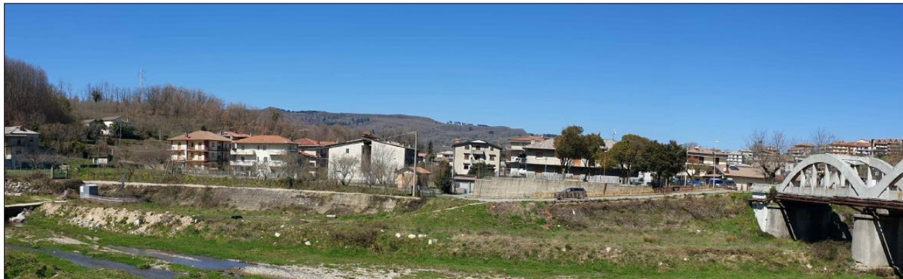
PUNTO 2: CENTRO ABITATO DI CARDINALE - Post operam
