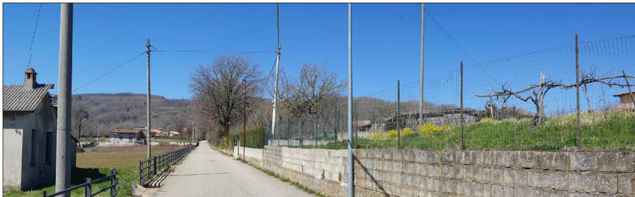
PUNTO 1: CENTRO ABITATO DI TORRE DI RUGGIERO - Post operam
