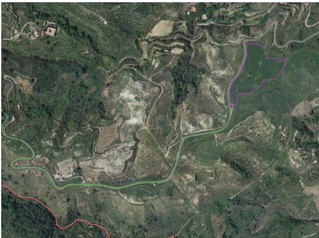
Figura 2-8: Ortofoto area di futura Stazione elettrica utente adiacente alla Stazione Terna "Soverato"
