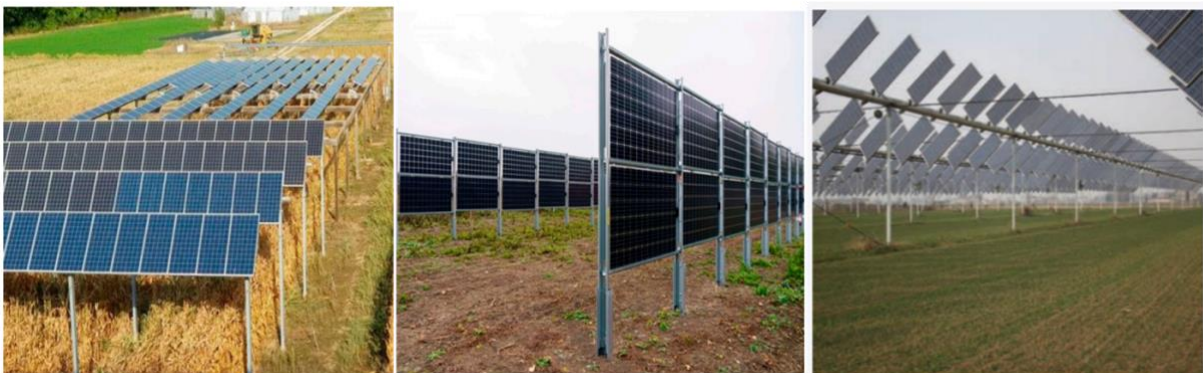
Figura 3. Esempi di differenti soluzioni agrivoltaiche: impianti fissi (Legambiente, 2020); moduli verticali; sistemi di inseguimento (Toledo e Scognamiglio, 2021); Sistema Agrovoltaico® ( https://remtec.energy/agrovoltaico ).
