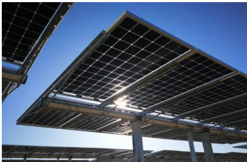
Figura 4.3 Esempio di struttura a tracker monoassiale.
