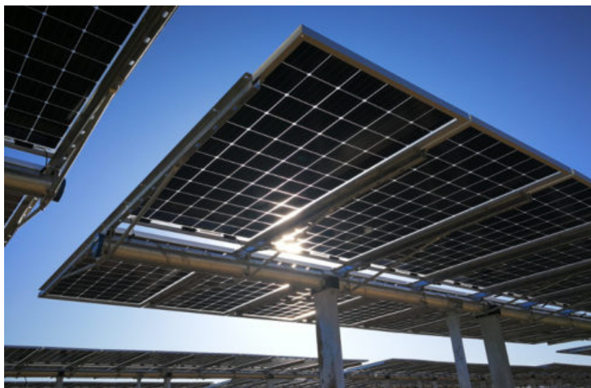
Figura 2.2 Esempio di struttura a tracker monoassiale.
