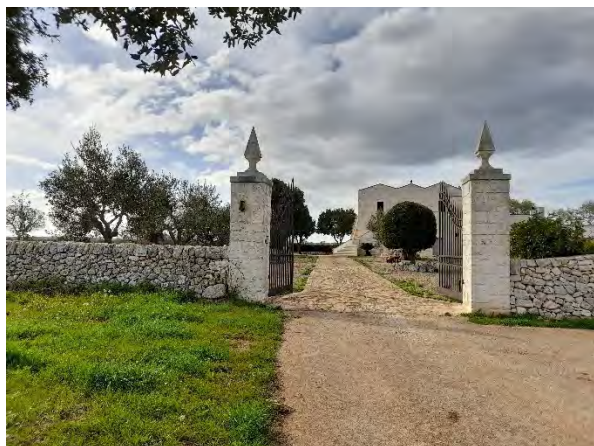
Tratto finale cavidotto all'ingresso Mass. Panzo Grande con visibilità nulla
