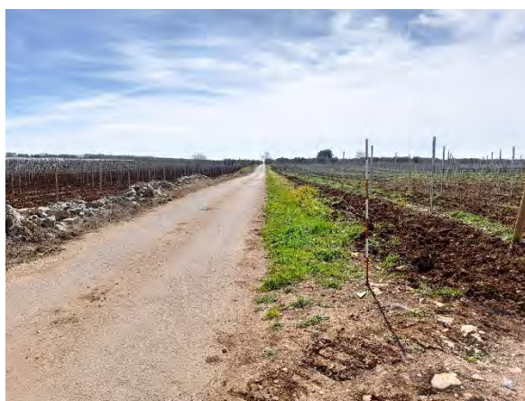
Parte N cavidotto in Strada Vicinale Traversa Mofetta
