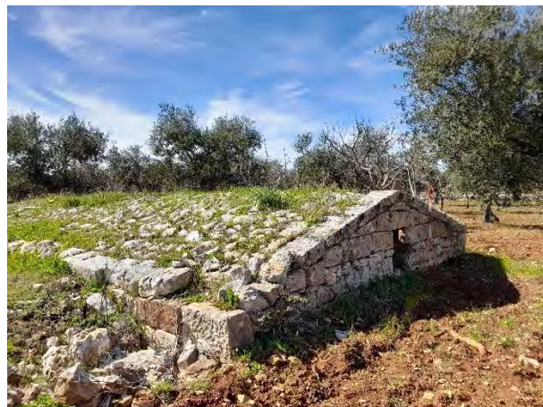
Inizio a N del tratturo perpendicolare a Strada Vicinale via Trelleme- struttura di una cisterna in pietre a secco
