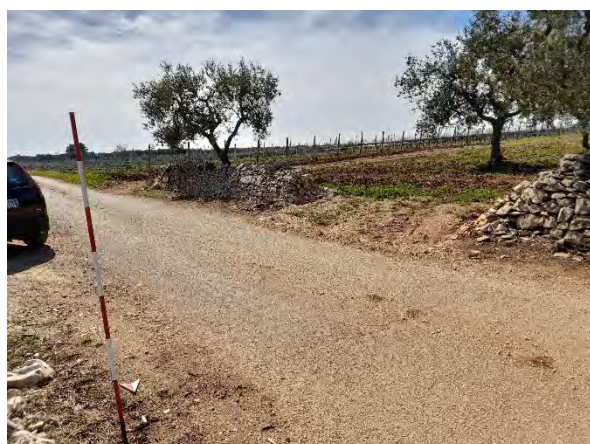
Parte N cavidotto in Strada Vicinale Traversa Mofetta
