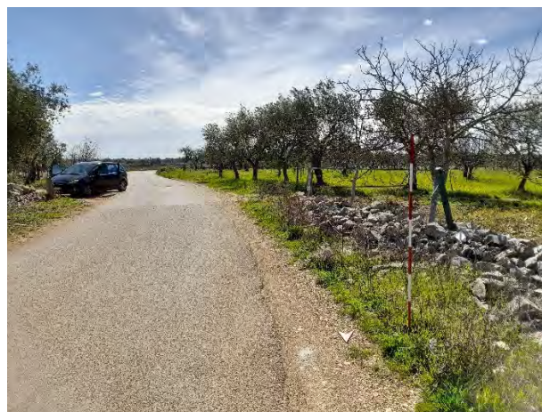
Tratto di cavidotto su strada comunale tra SP75 e SP125
