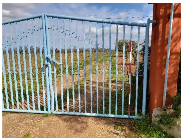
Ingresso inaccessibile UR 10 sulla SP 20
