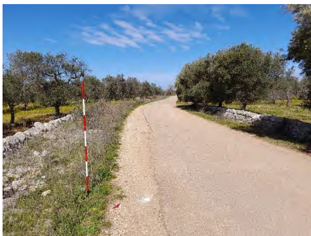
Tratto di cavidotto su strada comunale tra SP75 e SP125
