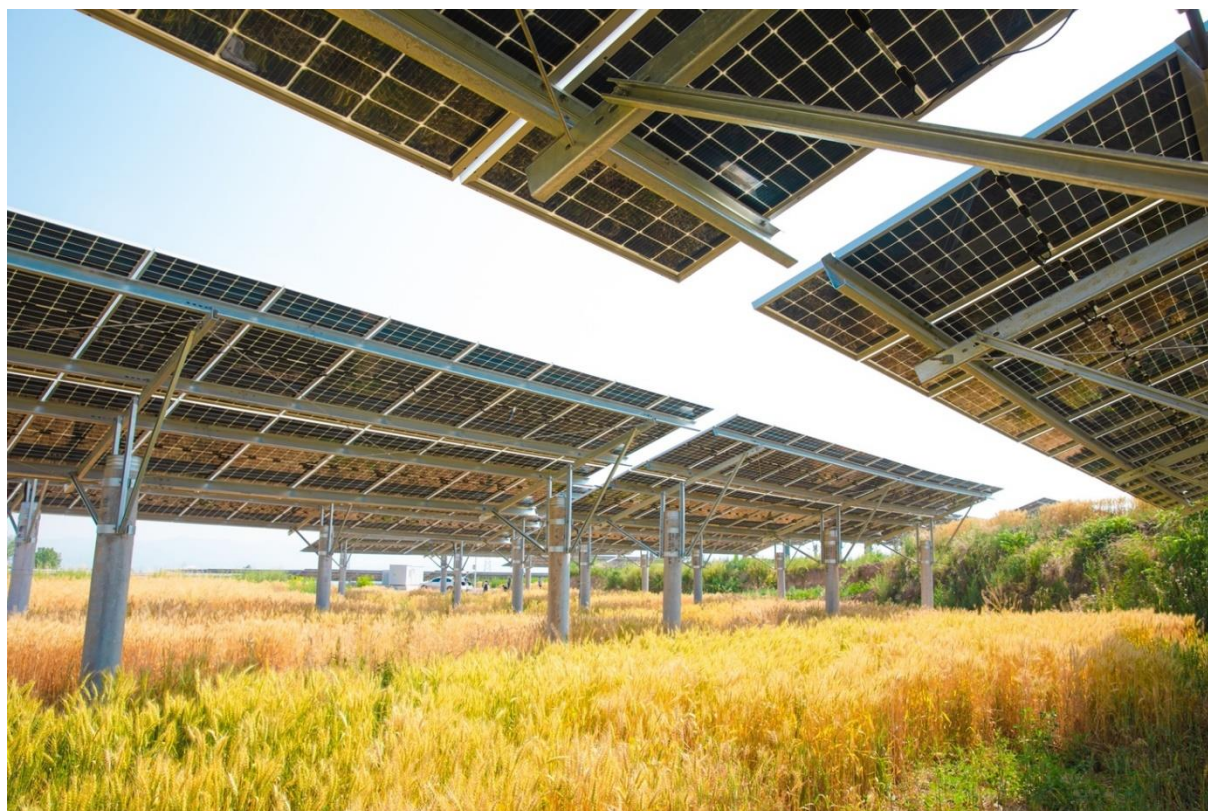
Figura 1.3: Frumento coltivato al di sotto dei pannelli fotovoltaici nelle campagne di Baoji (Cina, 2021)Fonte: https://www.longqi.com/us/news/6716/
