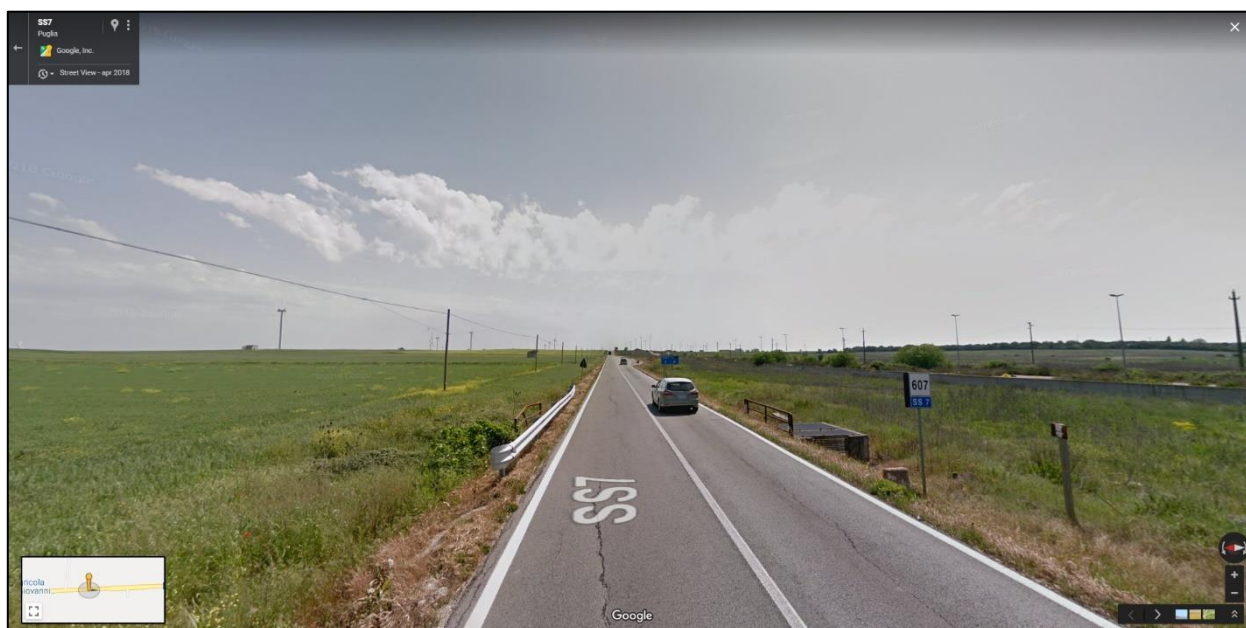
Figura 45- Canale da CTR n. 1 - km 607+006 della SS7
