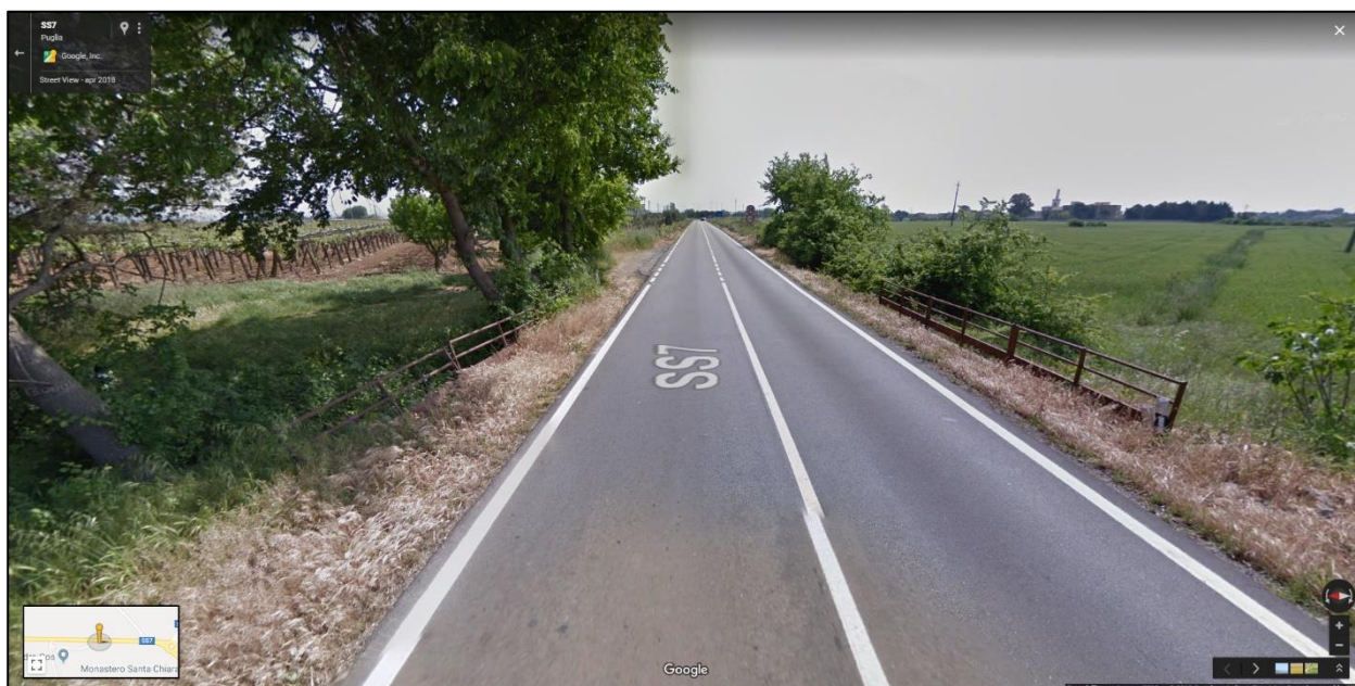
Figura 49- Canale da CTR n. 3 - km 611+631 della SS7
