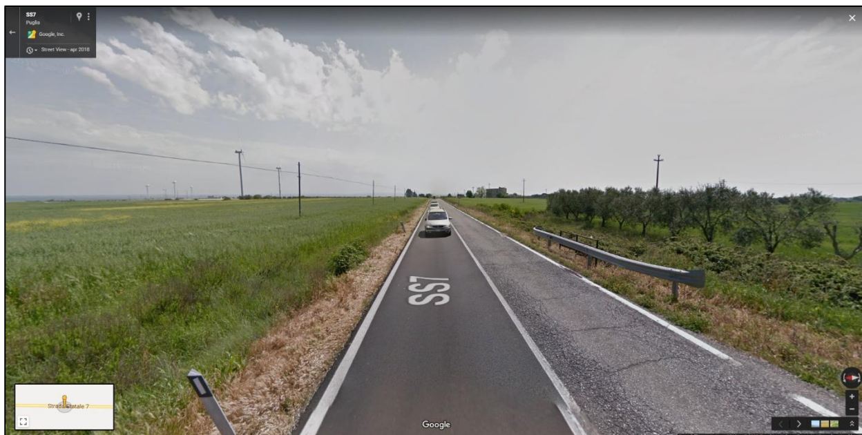
Figura 46- Canale da CTR n. 2 - km 608+547 della SS7
