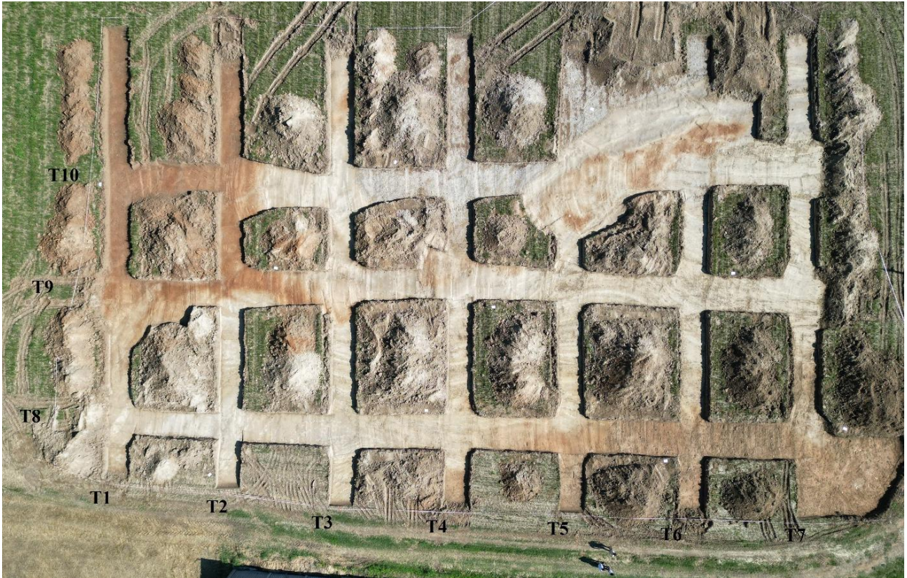
Fig.5- Vista aerea dell'area indagata con le trincee e gli ampliamenti effettuati
