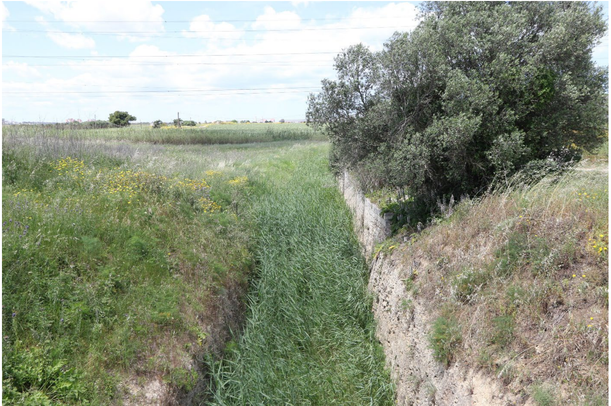
Figura 3: Canale di connessione al Fiume Grande
