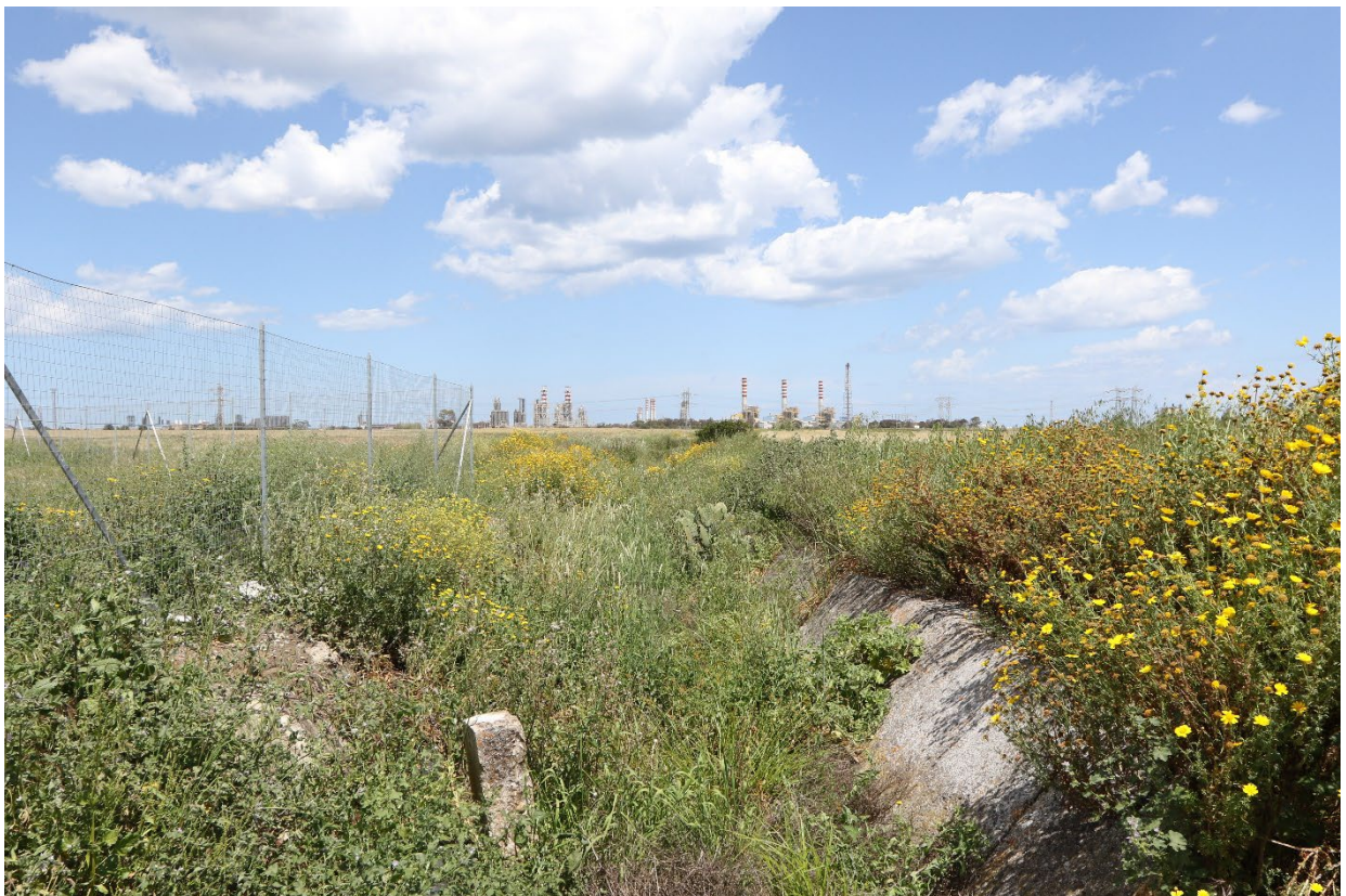
Figura 4: Canale a nord dell'impianto
