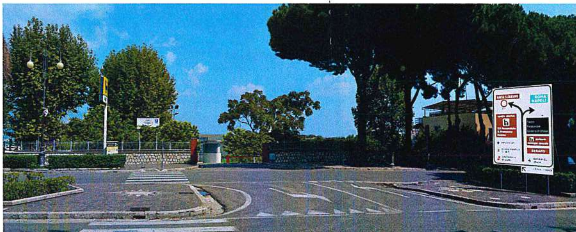
Fig.43.5 – Vista della Base Nautica dal lungomare Caboto in seguito alla realizzazione del progetto
