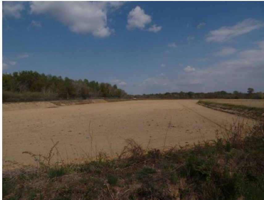
Foto 3: Panoramica del settore sud-est dell'impianto.
