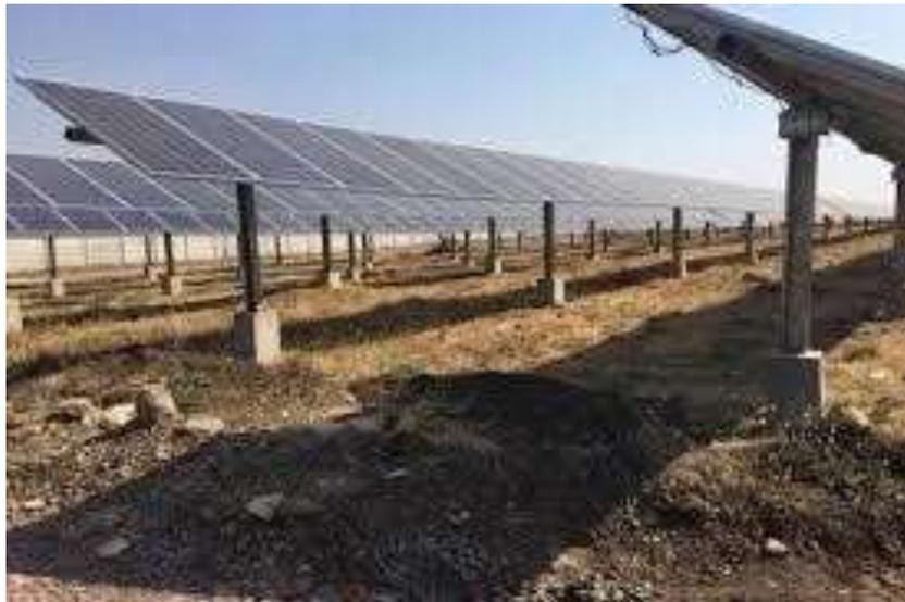
Figura 5: Esempio di impianto fotovoltaico con fondazioni ottenute mediante perforazione del terreno e successiva creazione del palo
