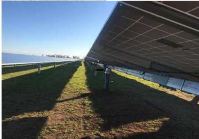
Figura 3: Esempio di impianto fotovoltaico realizzato con supporti costituiti da pali in acciaio infissi direttamente nel terreno. Gli impatti sul suolo sottostante risultano essere minimizzati
