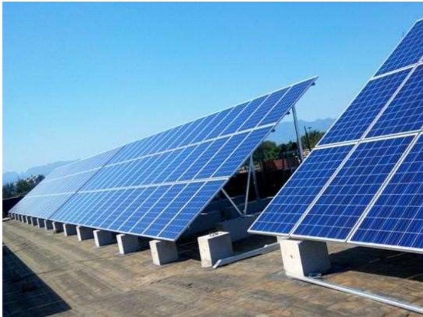
Figura 7: Esempio di impianto fotovoltaico con fondazioni formate da zavorre costituite da plinti in cemento
