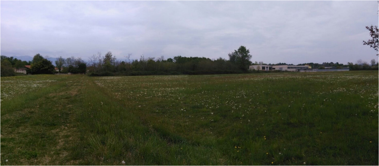
Figura 23. Area dove verrà realizzata la Stazione Elettrica 132/36 kV foto n. 5 vista da sud-ovest verso nord.
