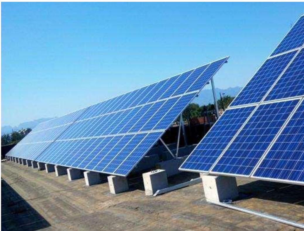
Figura 53 - Esempio di impianto fotovoltaico con fondazioni formate da zavorre costituite da plinti in cemento
