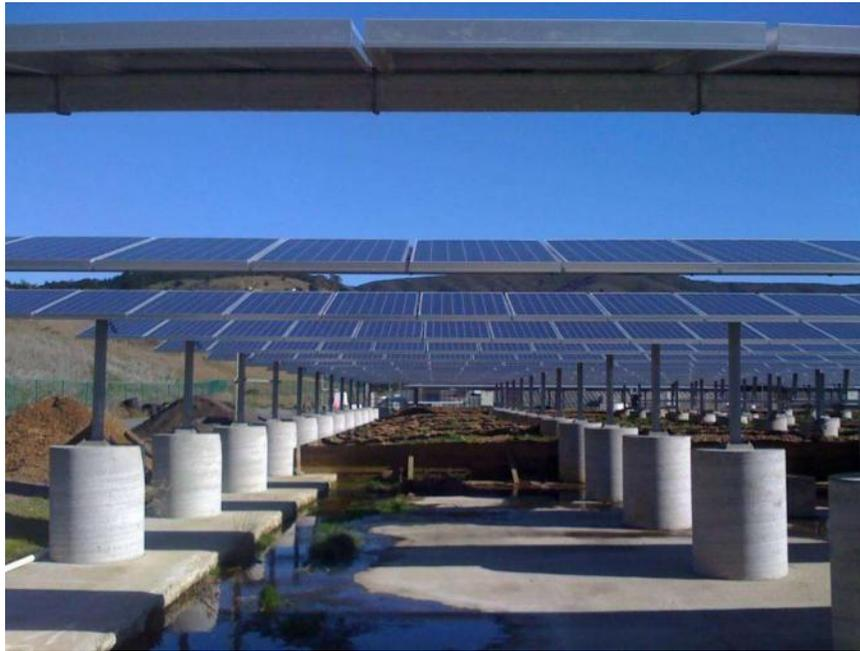
**Figura 52 - Esempio di impianto fotovoltaico con fondazioni ottenute mediante perforazione del terreno e successiva creazione del palo di fondazione con getto di cemento**
