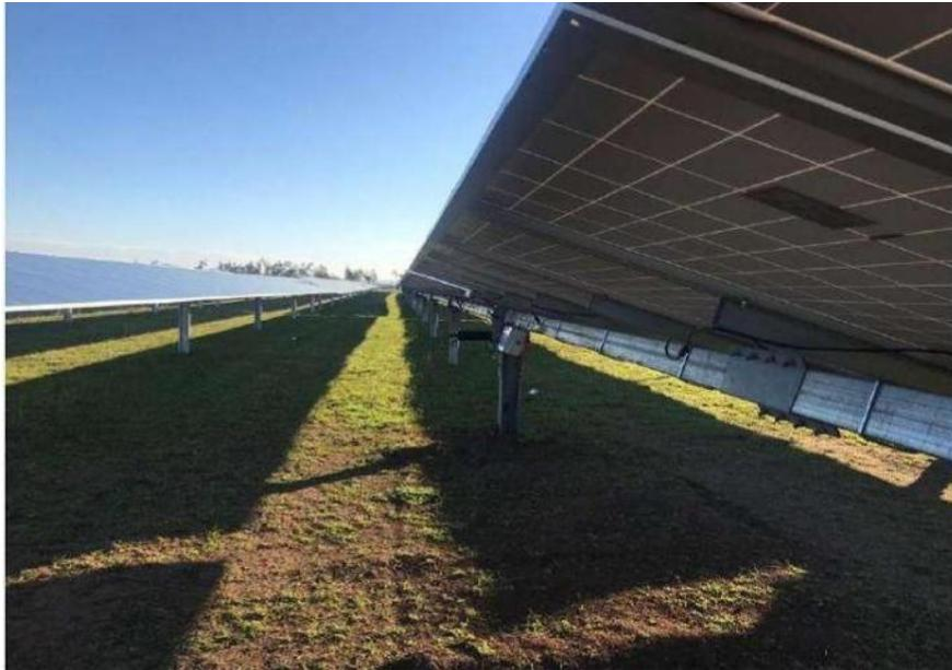
**Figura 49 - Esempio di impianto fotovoltaico realizzato con supporti costituiti da pali in acciaio infissi direttamente nel terreno. Gli impatti sul suolo sottostante risultano essere minimizzati**
