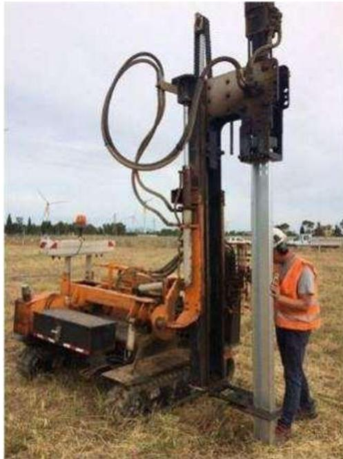
**Figura 48 - Esempio di supporto costituito da palo in acciaio infisso direttamente nel terreno mediante battipalo**
