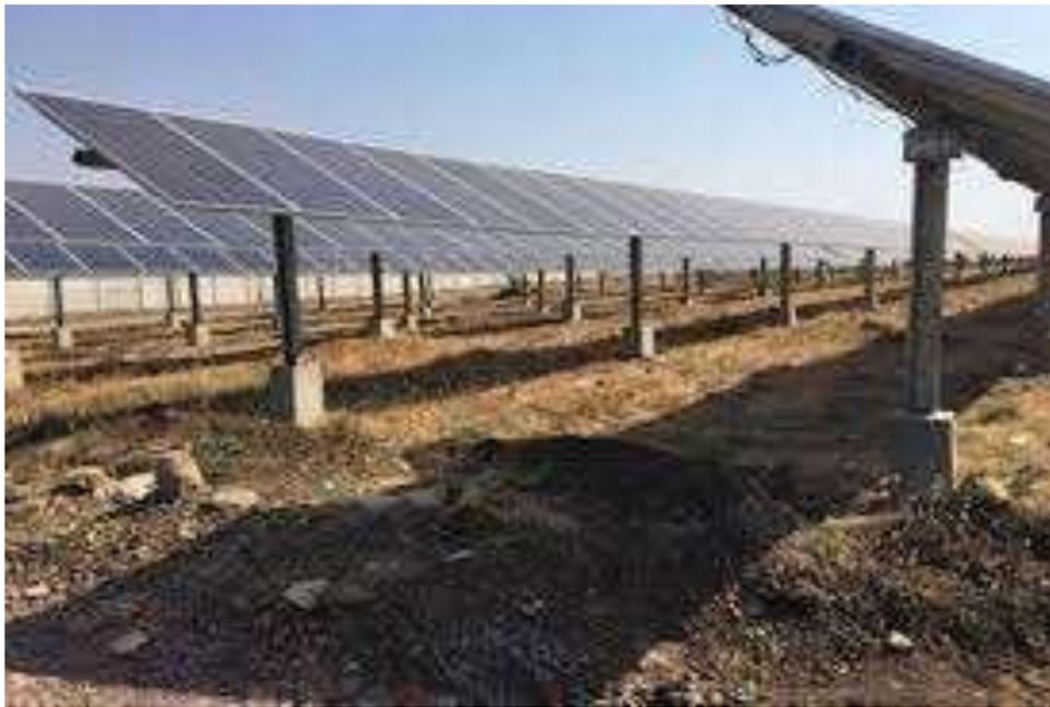
**Figura 51 - Esempio di impianto fotovoltaico con fondazioni ottenute mediante perforazione del terreno e successiva creazione del palo di fondazione con getto di cemento**
