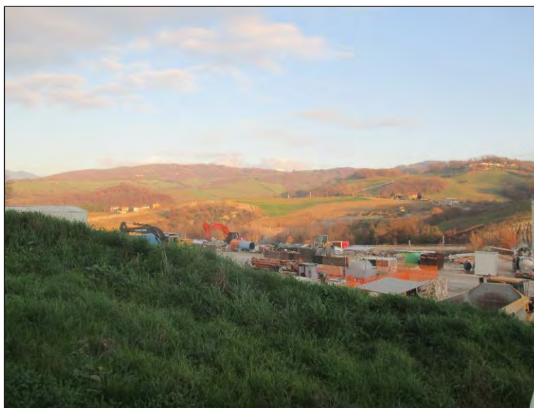
Cantiere Base località Piano dell'Abate VI C.O. gennaio 2023
