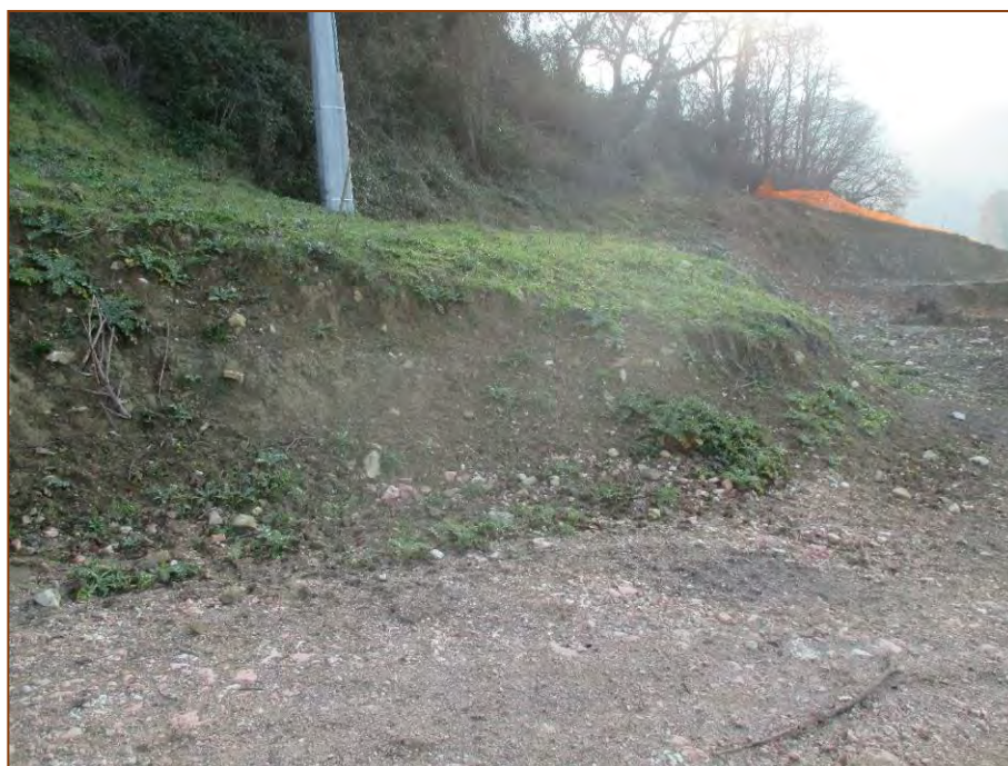
Particolare stazione di monitoraggio suolo SUOLO_01. Area cantiere viadotto "Tre Vescovi" VI campagna C.O. gennaio 2023
