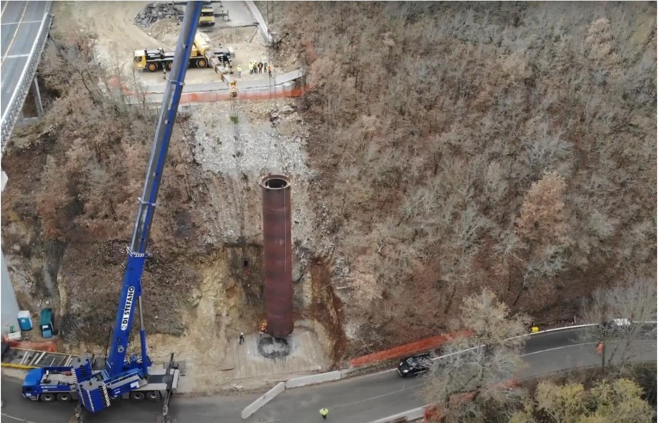
**Figure 2.** Posizionamento del guscio metallico in COR.TEN tramite gru, con evidenza delle armature di attesa dal plinto.
