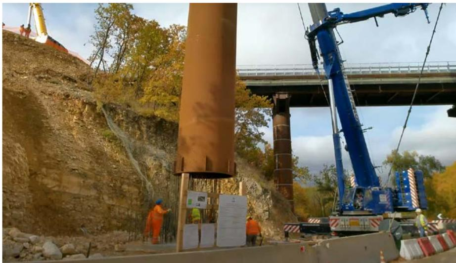
**Figure 3.** Posizionamento del guscio metallico in COR.TEN tramite gru, con evidenza delle armature di attesa dal plinto.
