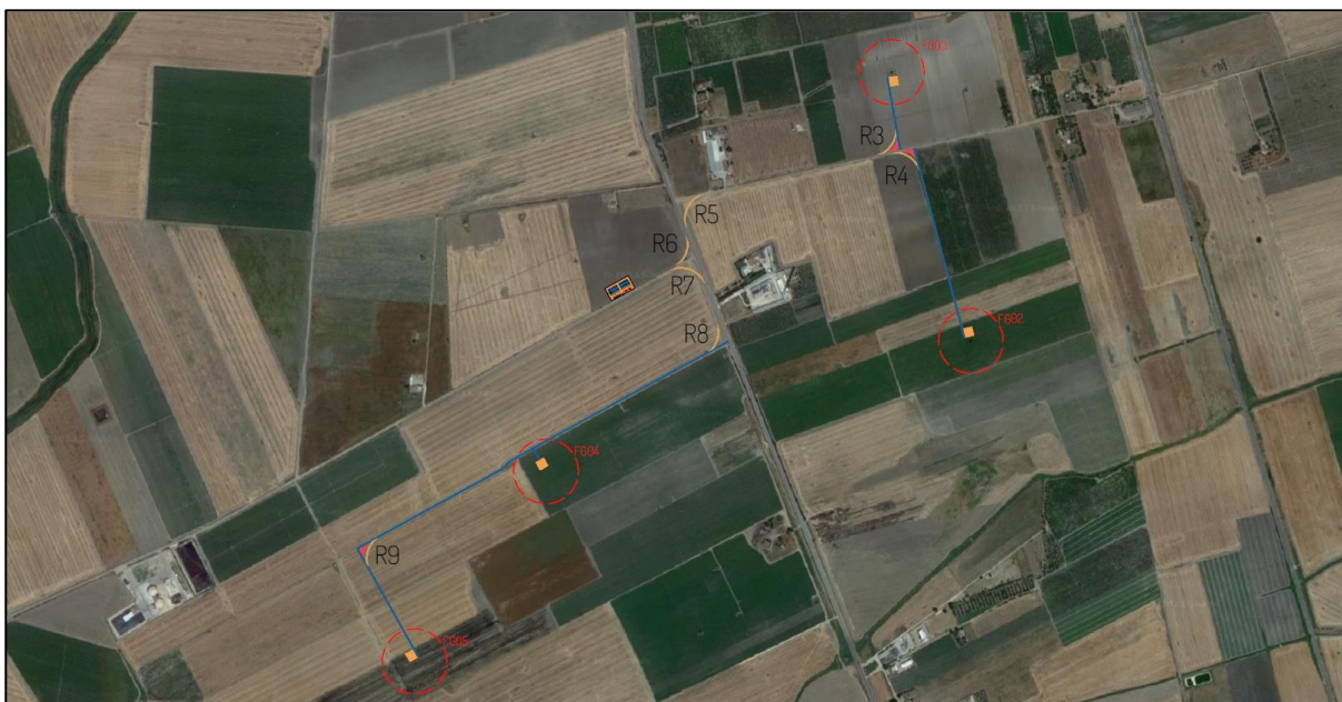
Figura 12: Dettaglio dell'area di studio. Rif. PD.EG.2.1 Viabilità di accesso WTG e area di cantiere
