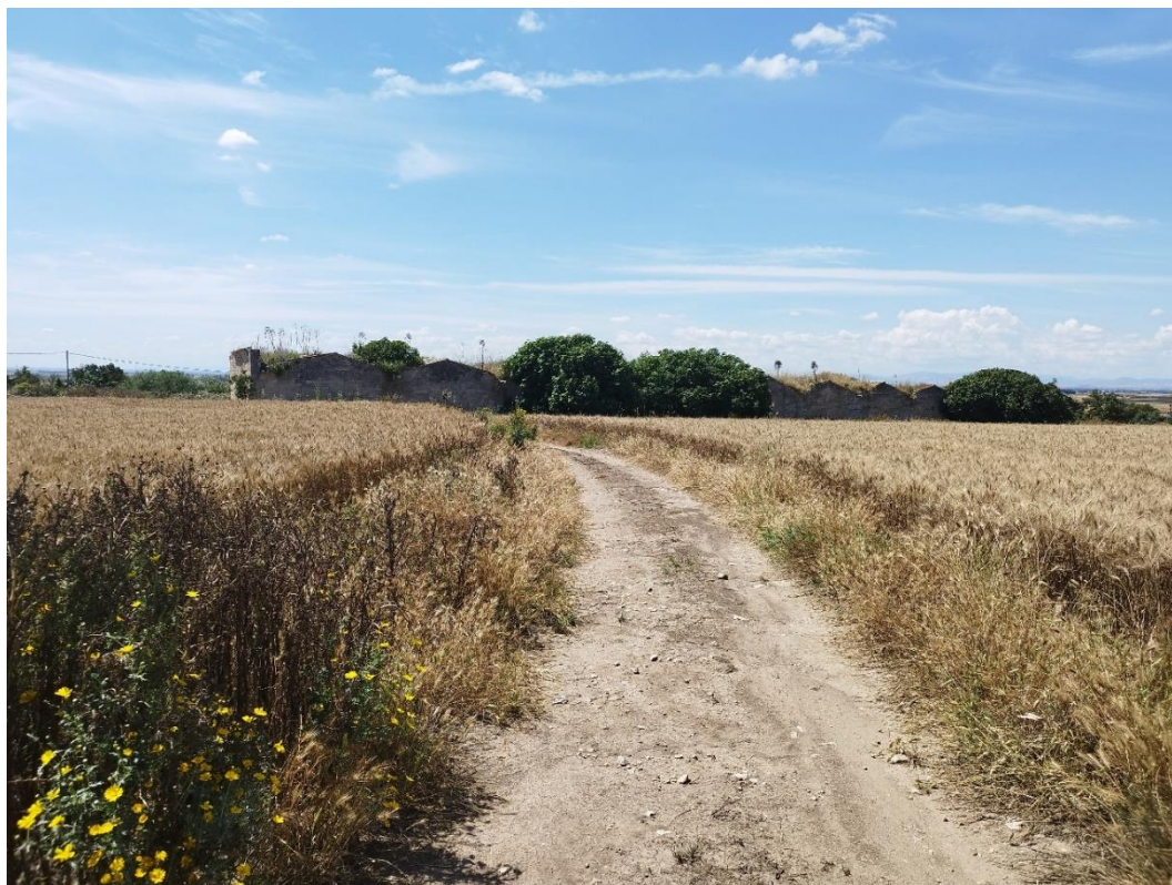
Foto 6: viabilità aerogeneratore FG01
