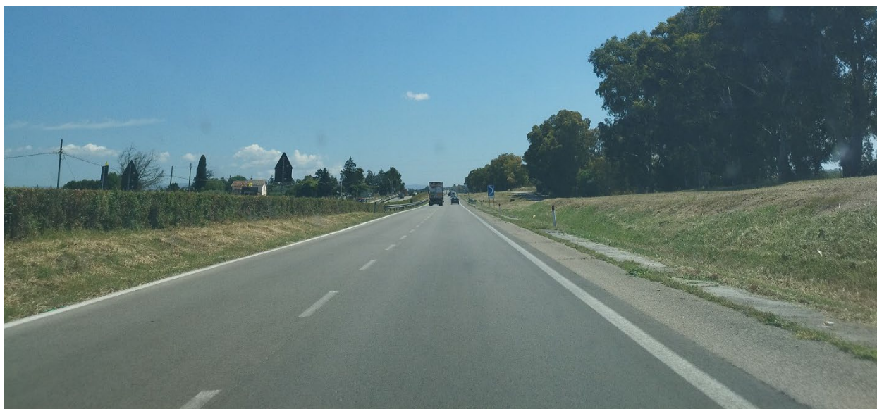
Viabilità in conglomerato bituminoso esistente in ottimo stato
