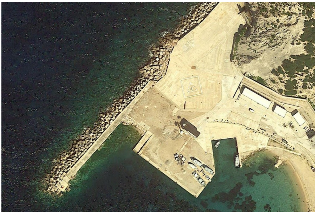
Figura 2.2 - Diga foranea di protezione del moto ondoso (anno 2013)
