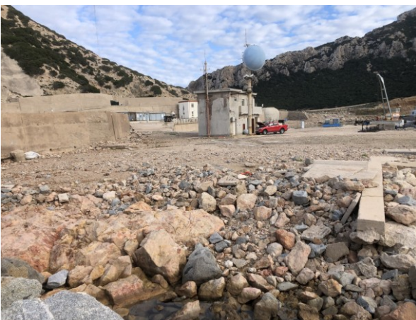
Consistenza dell'esistente pavimentazione del piazzale inferiore (zona retrostante ex coronamento)
