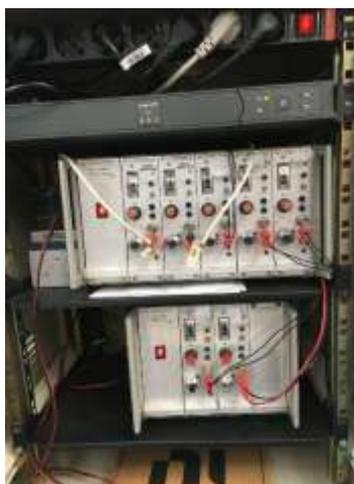
**Figura 7** Condizionatore di segnale per l'acquisizione dalle sonde di livello
