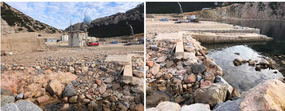
Consistenza dell'esistente pavimentazione del piazzale inferiore (zona retrostante ex coronamento)
