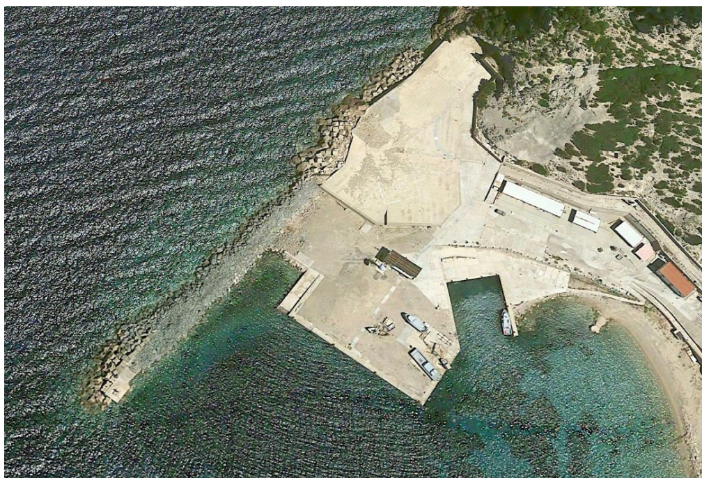
Figura 2.3 - Diga foranea di protezione del moto ondoso (settembre 2020)
