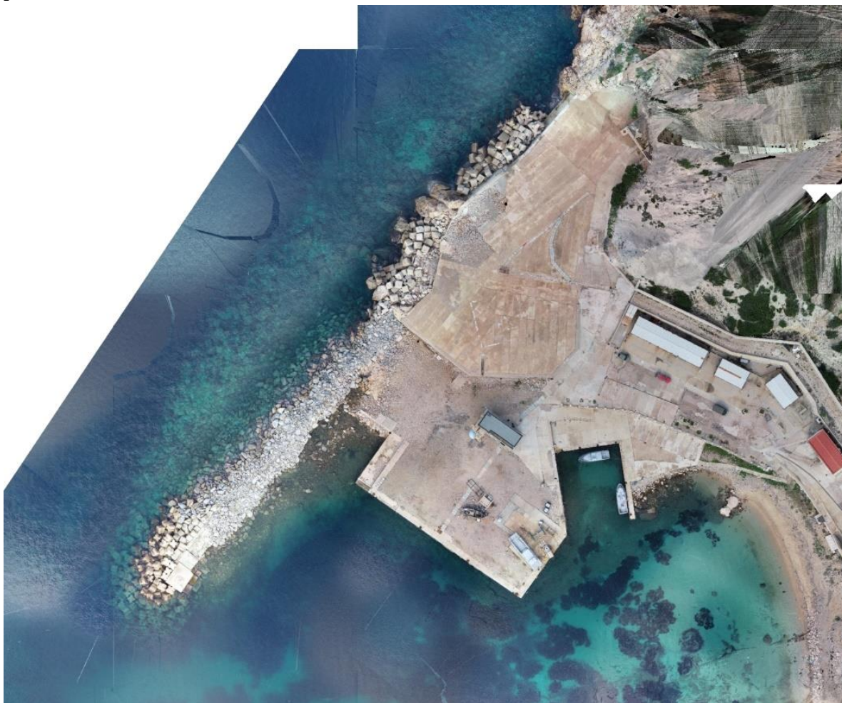
Figura 2.6 – Immagine desunta dal rilievo fotogrammetrico eseguito con drone il 22.12.2021
