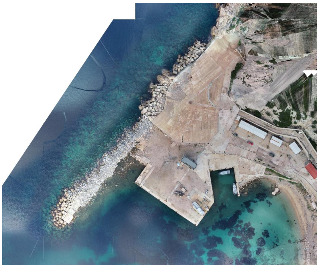
Figura 7.6 - Foto generale dell'area di intervento allo stato attuale rilevato tramite sopralluoghi effettuati tramite VOLI AEREI (SAPR) nell'area vasta di studio
