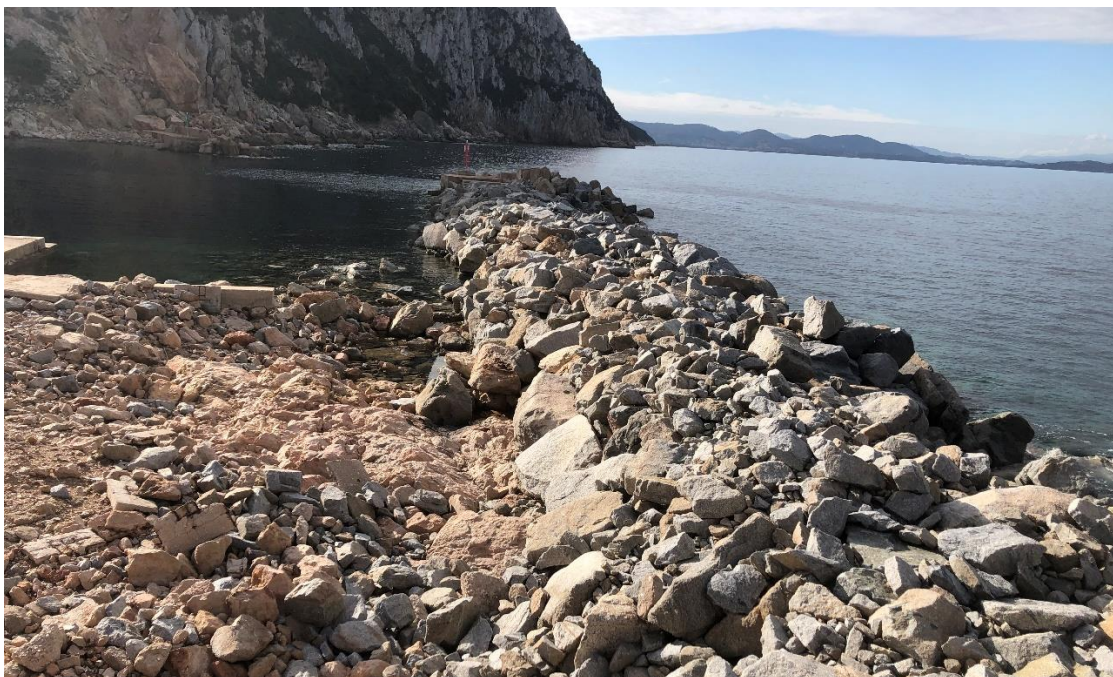
Figura 2.5 – Situazione attuale del coronamento a seguito interventi IMMEDIATE WORKS Phase-1
