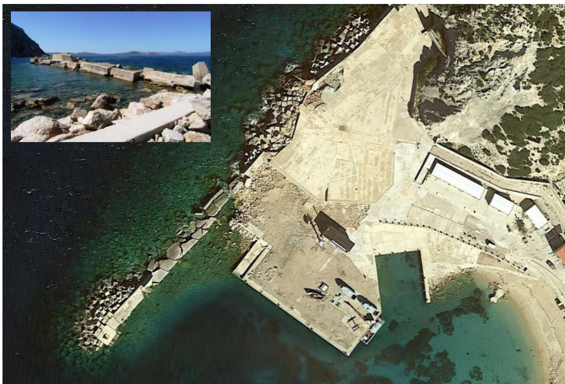
Figura 2.4 – Danneggiamento subito dalla diga foranea e dal coronamento a seguito della mareggiata del 5 Marzo 2015
