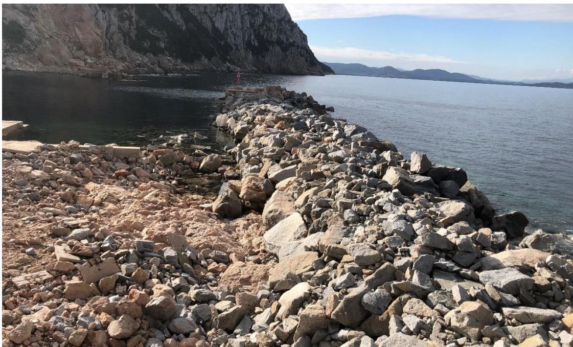
Figura 2.3 – Situazione attuale del coronamento
