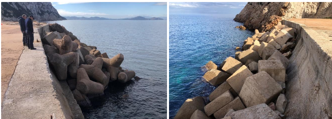
Situazione attuale della scogliera alla radice (tratto di protezione piazzale superiore)
