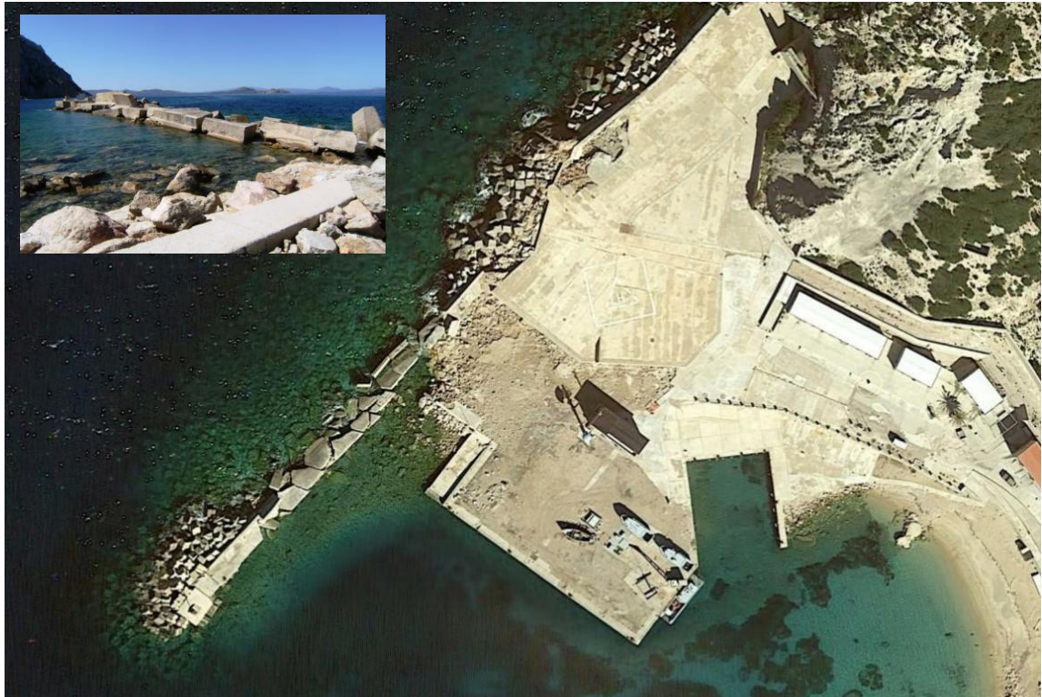
Figura 2.2 – Danneggiamento subito dalla diga foranea e dal coronamento a seguito della mareggiata del 5 Marzo 2015
