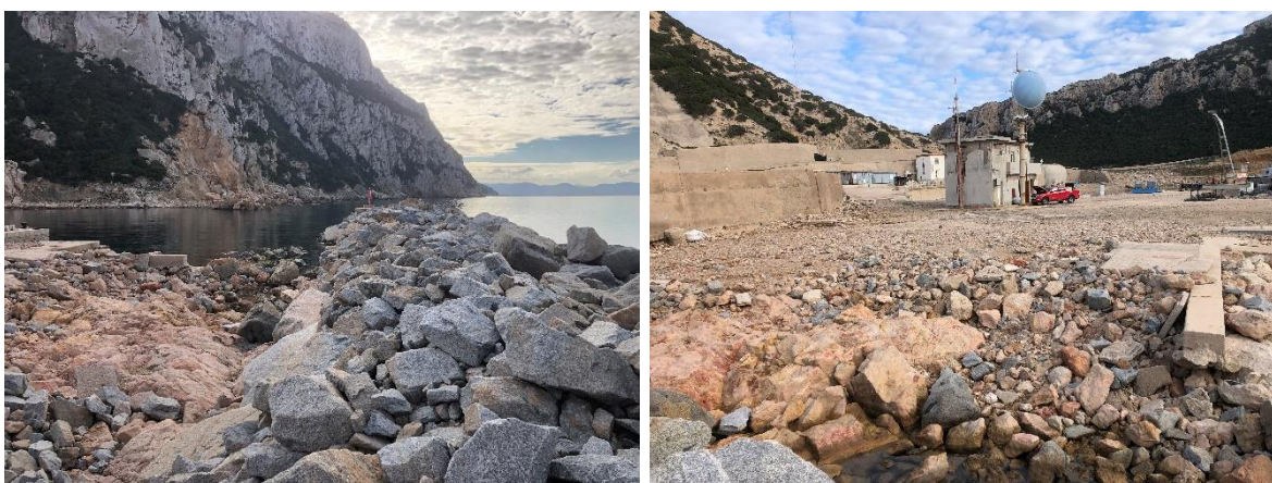
Stato attuale del piazzale inferiore in corrispondenza della radice della diga foranea
