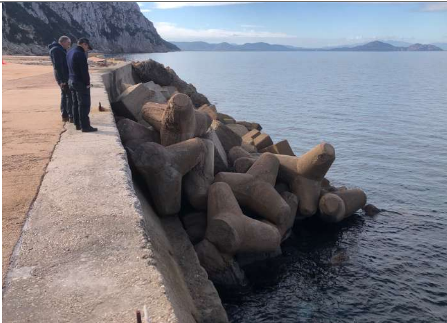
Foto 2. Particolare di dettaglio dell'area di radice del molo di progetto con Tetrapodi in cementizi. (rilievo del 22.12.2021)
