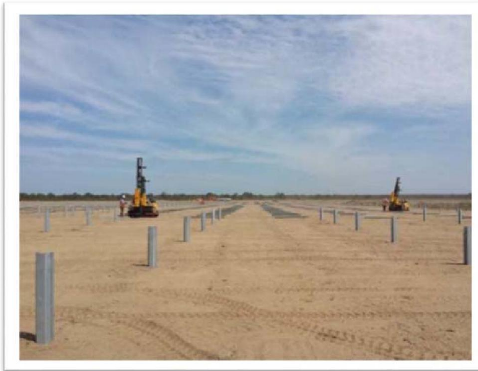
Figura 6.5. – Foto esempio di impianti realizzati con stessa struttura e stessi moduli fotovoltaici
