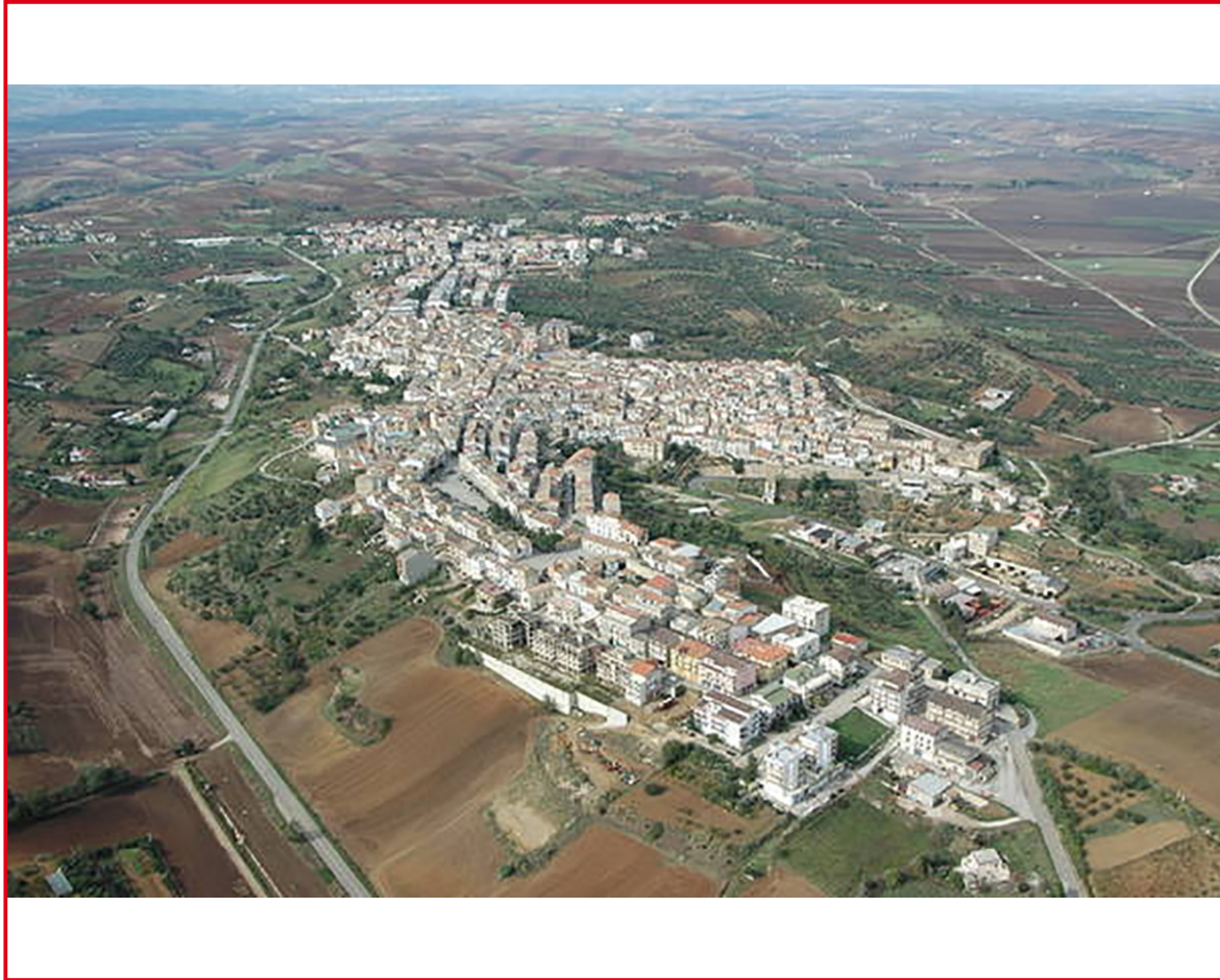
Fig. 4. Palazzo San Gervasio. Centro abitato.
