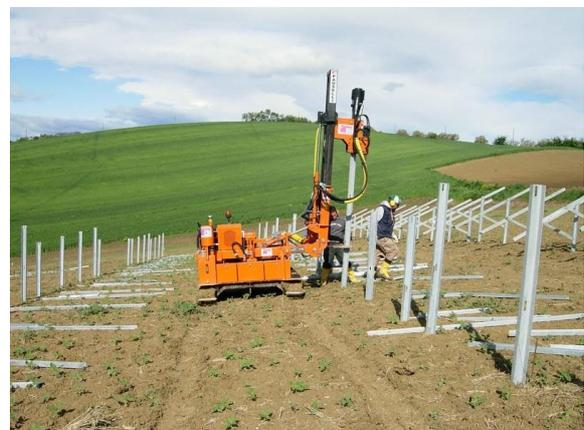
Figura 3 - Posa strutture metalliche di fondazione
