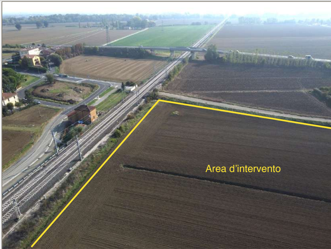
Figura 6: Veduta sul rilevato FS che delimita morfologicamente l'area in esame lungo il Confine NE
