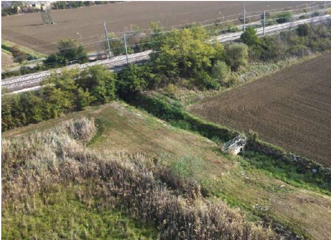
Figura 5-18 – Vista sulla Fossa Galli in corrispondenza della tombinatura di attraversamento della Linea FS
