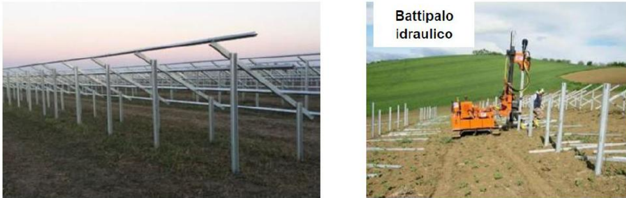
Figura 6-1 – Esempio di posa delle strutture portanti.
