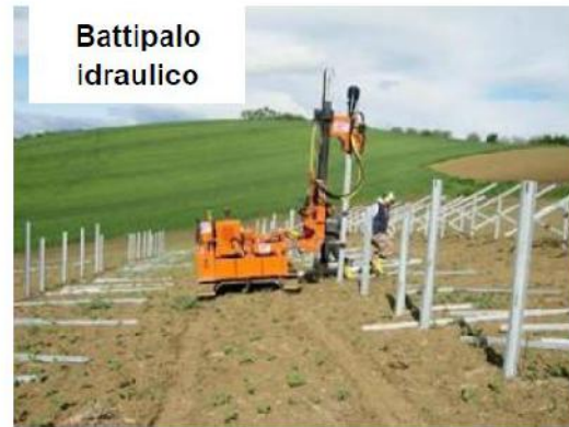
Figura 6-1 – Esempio di posa delle strutture portanti.
