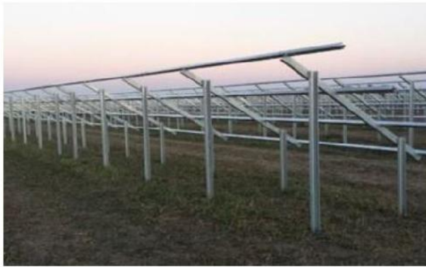
Figura 6-1 – Esempio di posa delle strutture portanti.
