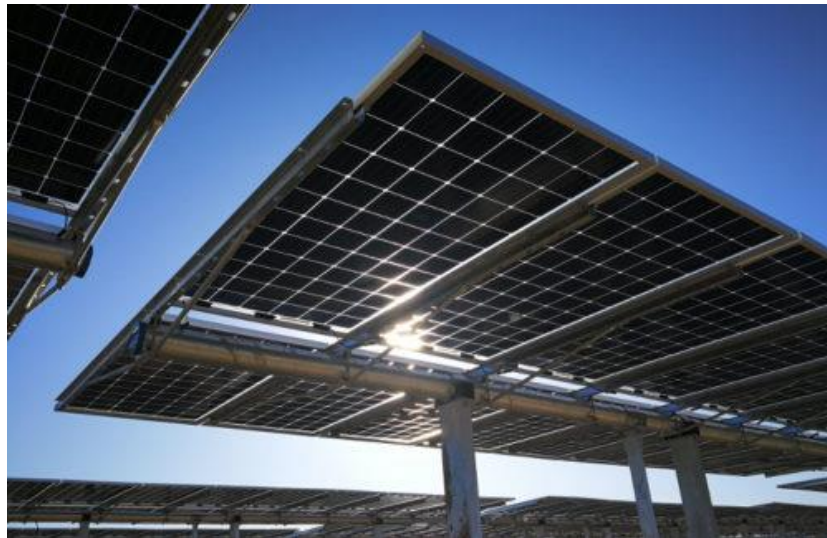
Figura 3.4 - Esempio di struttura a tracker monoassiale 2p
