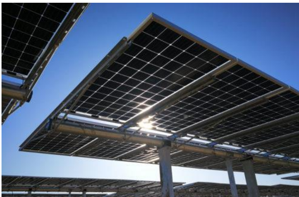
Figura 4.3 - Esempio di struttura con tracker monoassiale 2p
