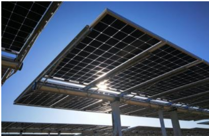
Figura 3.3: Esempio di struttura a tracker monoassiale
