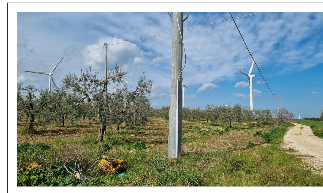
PUNTO DI PRESA FOTOGRAFICO 10
