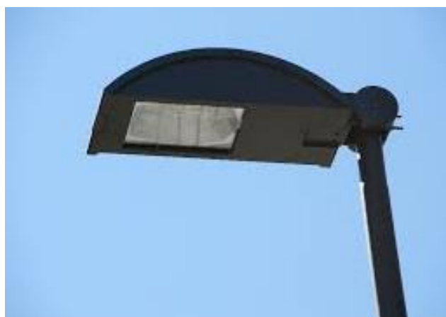
Figura 4.51: Esempio di apparecchio completamente schermato (full-cut-off).
