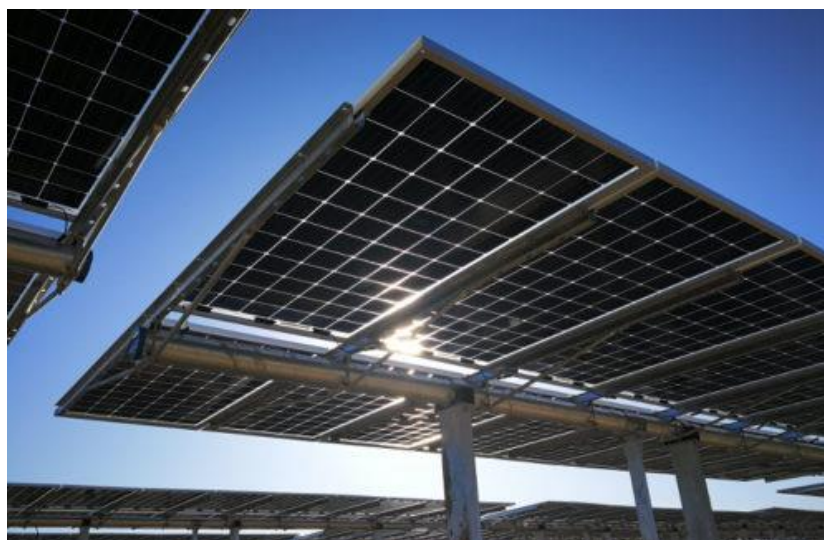
Figura 2.38 - Esempio di struttura a tracker monoassiale 2p
