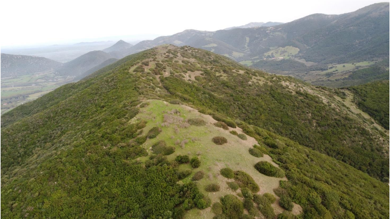
Figura 7.10 – Veduta sull’area di installazione della VI01 nella porzione occidentale dell’impianto. Ripresa aerea da ovest verso est
