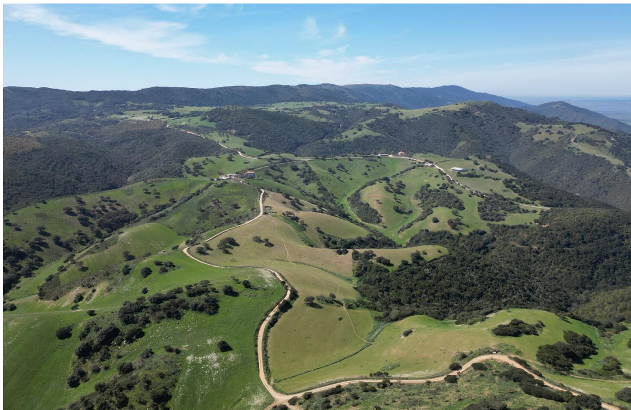
Figura 5.17 – Viabilità esistente verso la postazione VI07 (ripresa aerea da nord-est)
