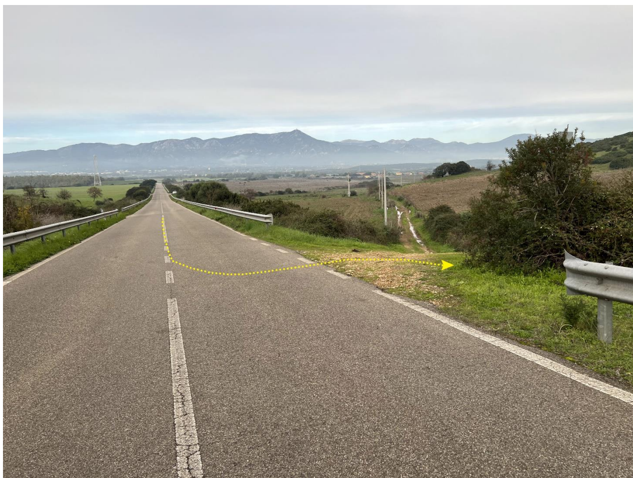
Figura 5.6 - Accesso al Cluster Ovest dalla S.P.85 in località P.ta su Conventu (direzione nord)
