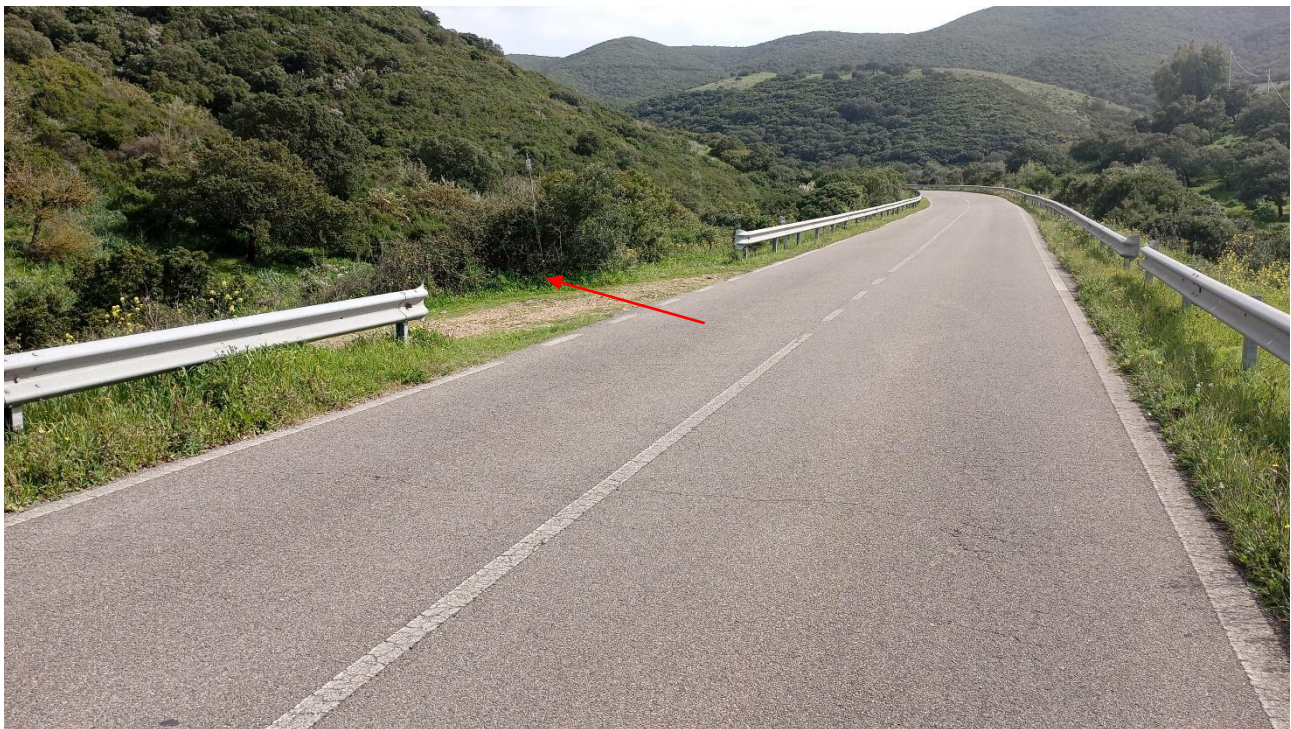
Figura 7.13 – Punto di innesto della viabilità secondaria sulla SP 85 in località P.ta Su Cunventu. Foto scattata da nord verso sud
