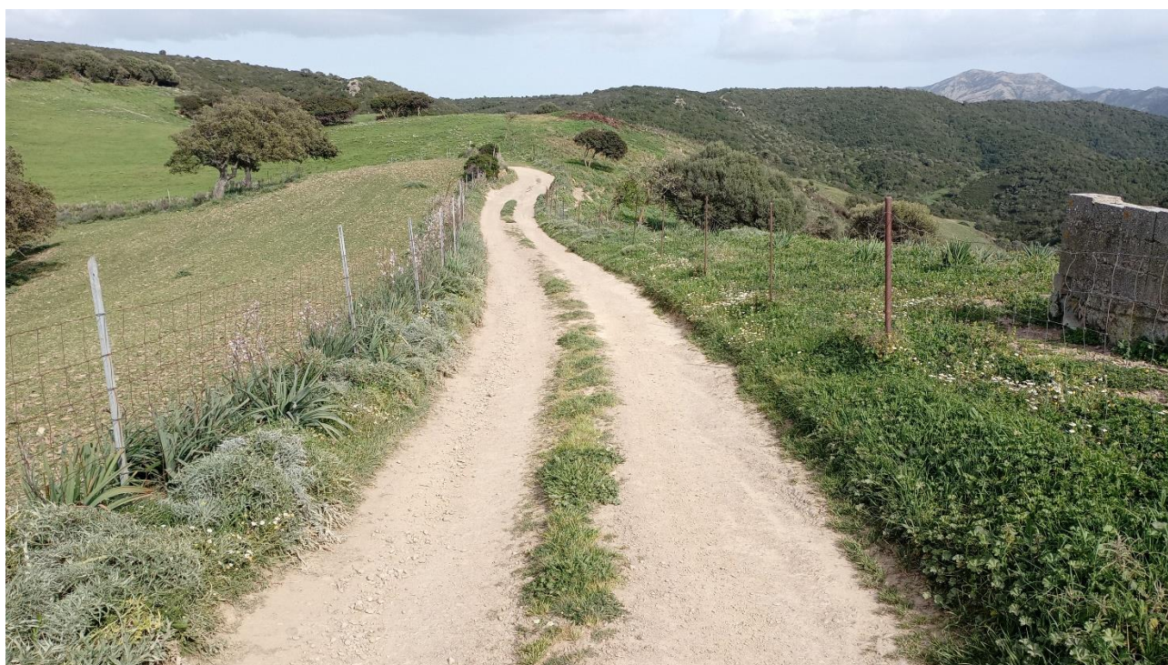
Figura 5.16 – Percorso rurale esistente di accesso alla postazione eolica VI06 (vista verso nord-est)
