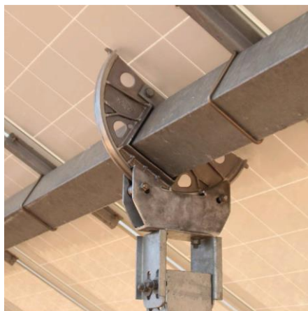
figura : schema nodo trave continua / colonna
