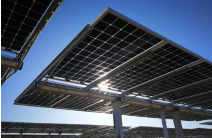
Figura 3.3: Esempio di struttura a tracker monoassiale
