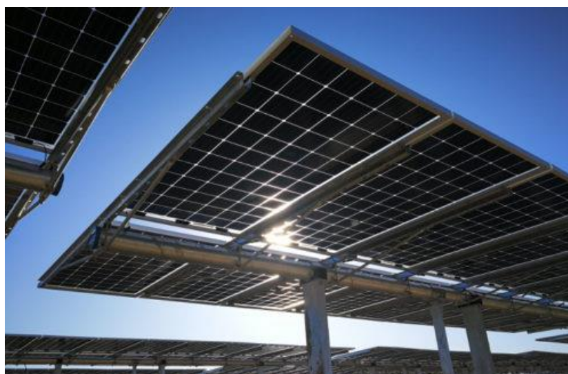
Figura 2.12 Esempio di struttura a tracker monoassiale 2p.
