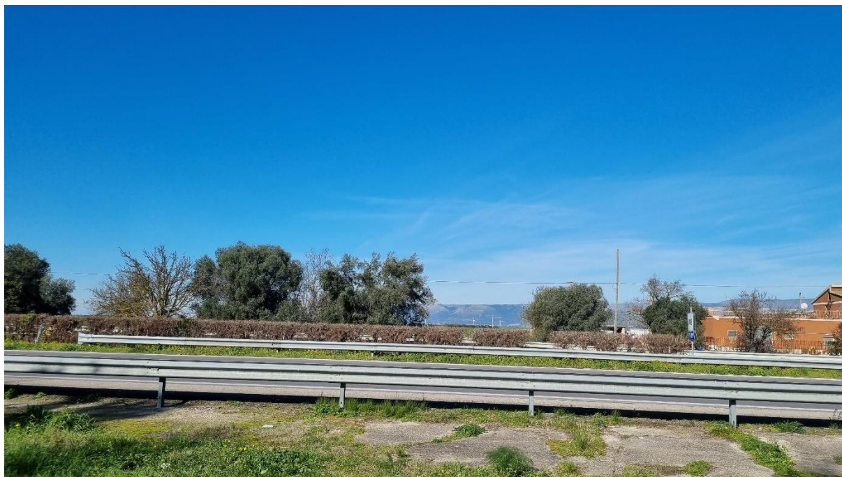
Figura 5.5: Punto di Presa Fotografica n. 10
