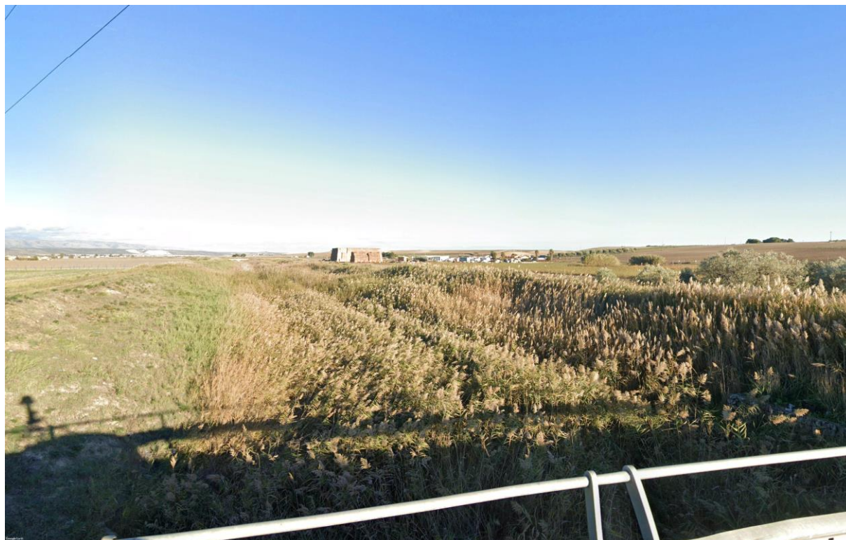
Figura 4.100: Torrente Celone in prossimità dell'area di intervento
