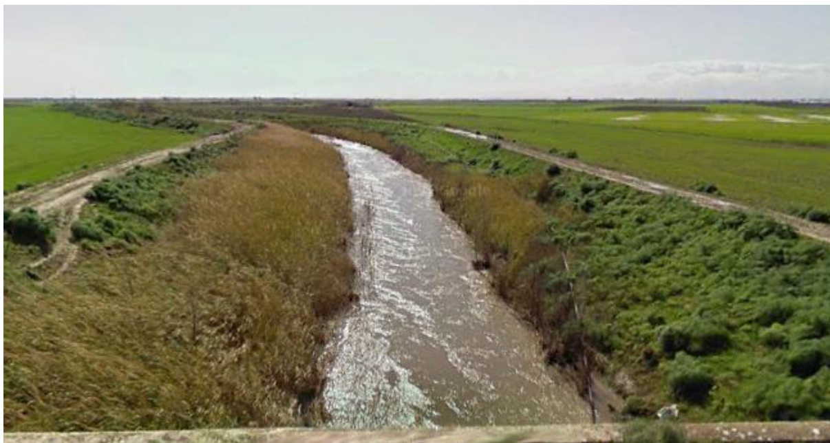
Figura 4.42: Dettaglio dell'attraversamento della SP24 sul Torrente Celone.
