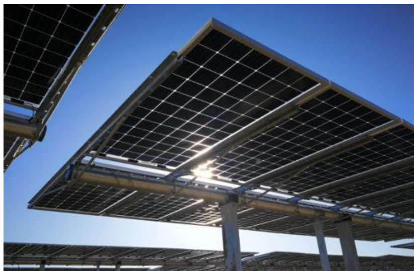
Figura 2.42 - Esempio di struttura a tracker monoassiale 2p
