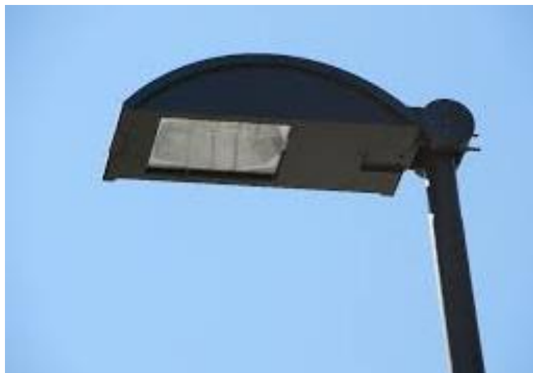
Figura 4.58: Esempio di apparecchio completamente schermato (full-cut-off).
