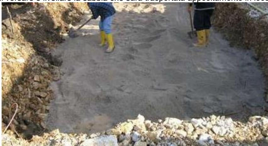
**FIGURA 16 - SBANCAMENTO PIANO POSA CABINE**
