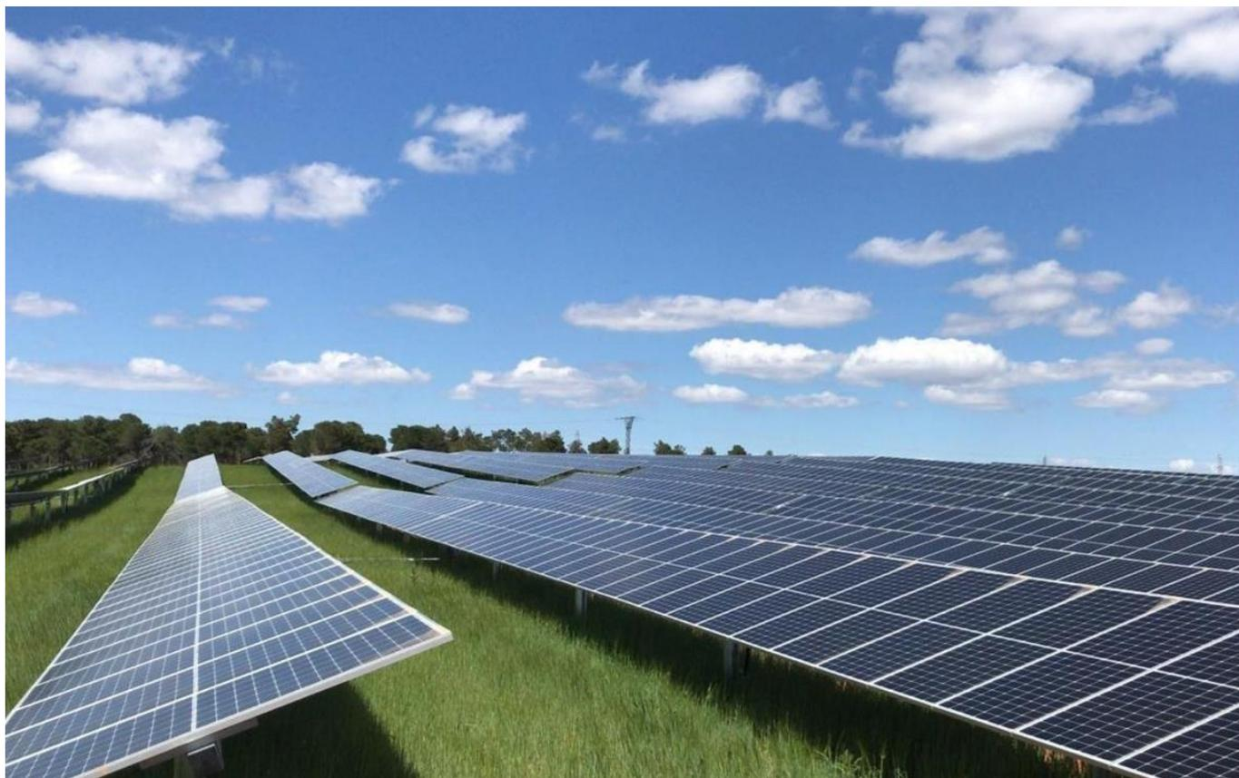
L'impianto fotovoltaico è costituito dunque da inseguitori solari disposti lungo l'asse Nord – Sud tali per cui i moduli fotovoltaici inseguono il sole da Est a Ovest.
