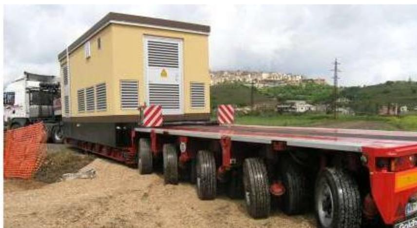
**FIGURA 7 - INSTALLAZIONE CABINE**
