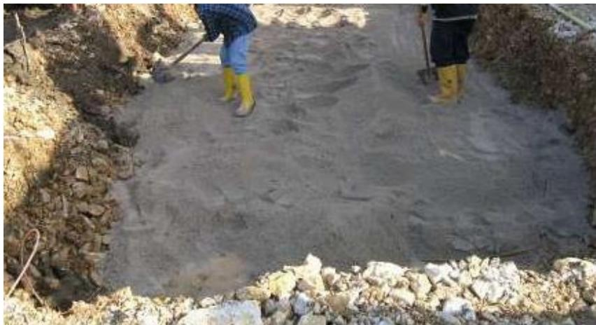
**FIGURA 6 - SBANCAMENTO PIANO POSA CABINE**
