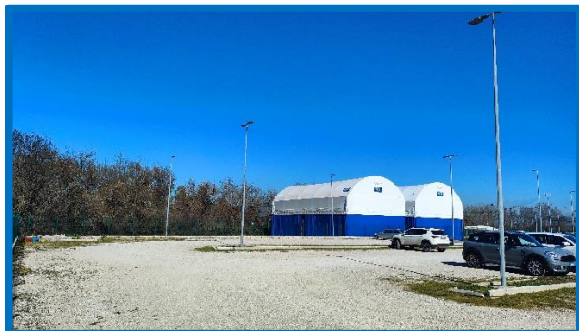
VISTA 1 – SUD IMPIANTO - APRILIA SPORTING VILLAGE
