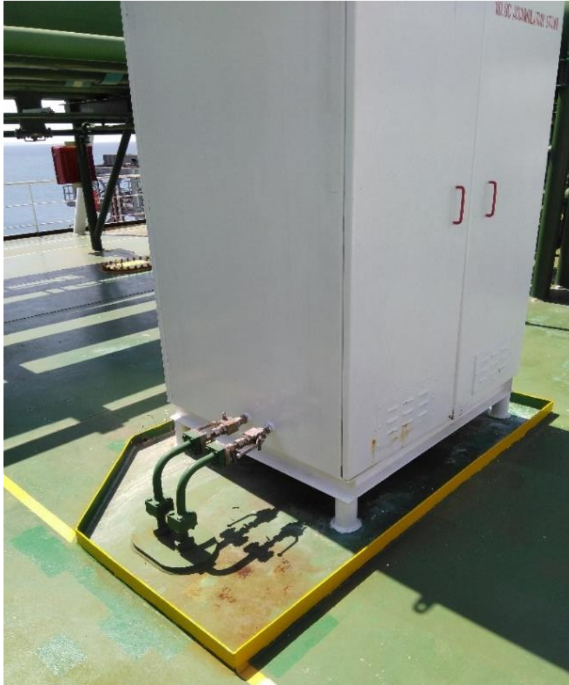
Figura 5 – Area impermeabile e cordolata con tappo al di sotto dell'armadio metallico accumulatori oleodinamici (punto 4.d)
