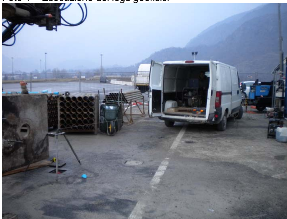
Foto 1 – Esecuzione dei logs geofisici
